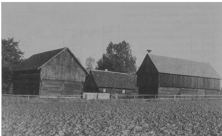
Ryc. 5. Najczęściej spotykany układ trzybudynkowej zagrody ołęderskiej. Zagroda ołęderska prezentowana na terenie Wielkopolskiego Parku Etnograficznego w Dziekanowicach (WPE), (stan z 1993 r.), foto A. Ziółkowski
