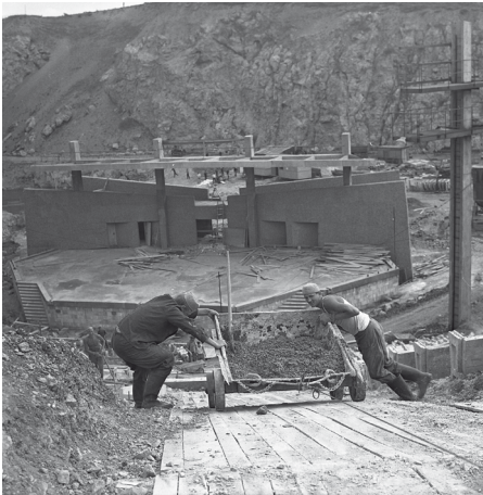
Budowa amfiteatru na Kadzielni, 1970 r., fot. Janusz Buczkowski
