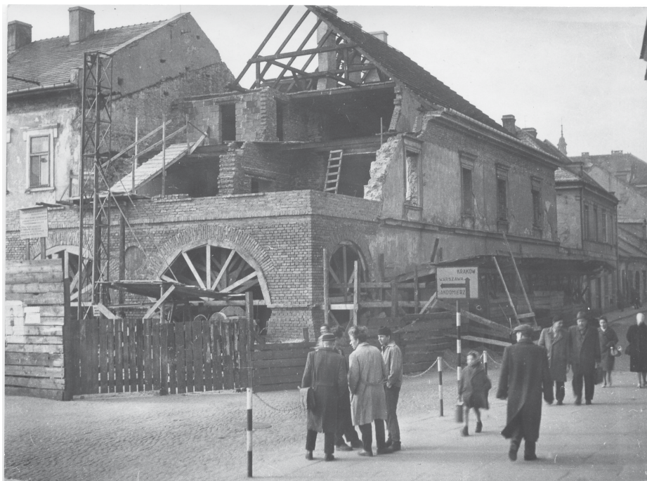
Remont kamienicy Sołtyków, 1961 r., fot. Jerzy Kamoda
