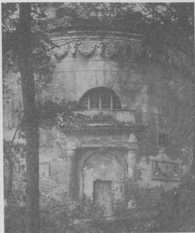
Fig. 7. Kuchnia w Królikarni. Stan z początku XX wieku (fotografia w zbiorach IS PAN, fot. J. Kłos)
