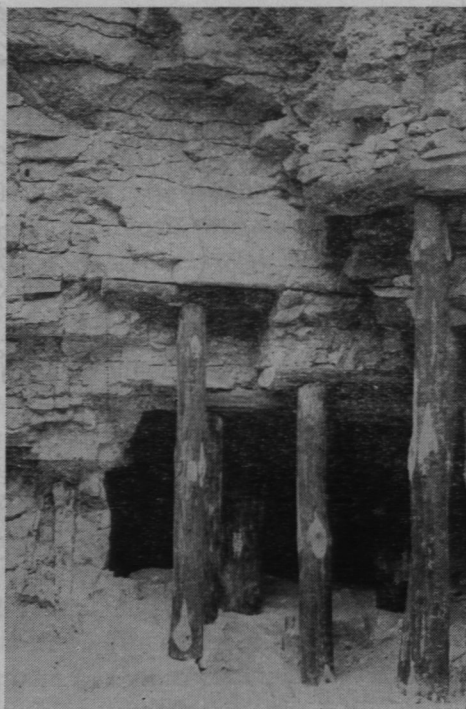
Ryc. 7. Stemplowanie drewnianymi kopalniakami stropów. Wg M. Drewki
