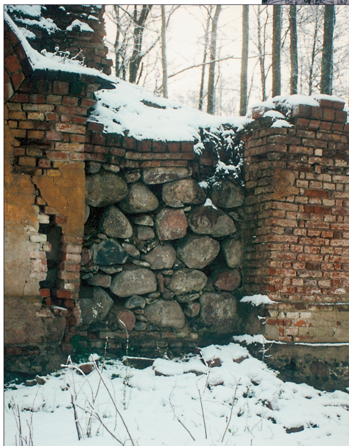
Fig. 8. Grobowiec rodziny Farenheid, fragment elewacji zachodniej, 1992, fot. B. Piątek.
