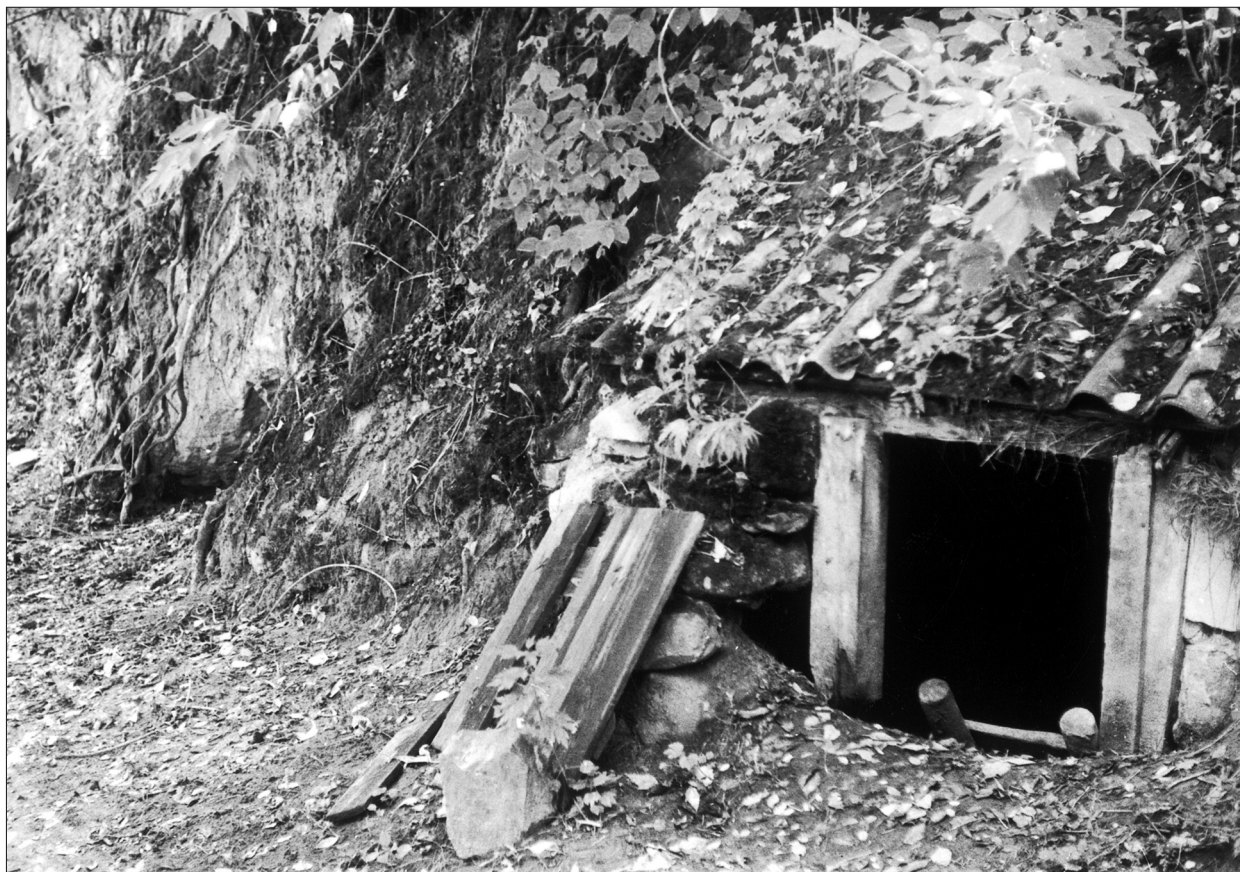
Fig. 5. Komorna k. Kleczanowa. Współczesna piwnica wydrążona w lessie, o formie i wielkości zbliżonej do prezentowanej na fig. 4, przykryta drewnianym daszkiem. Fot. A. Buko.
