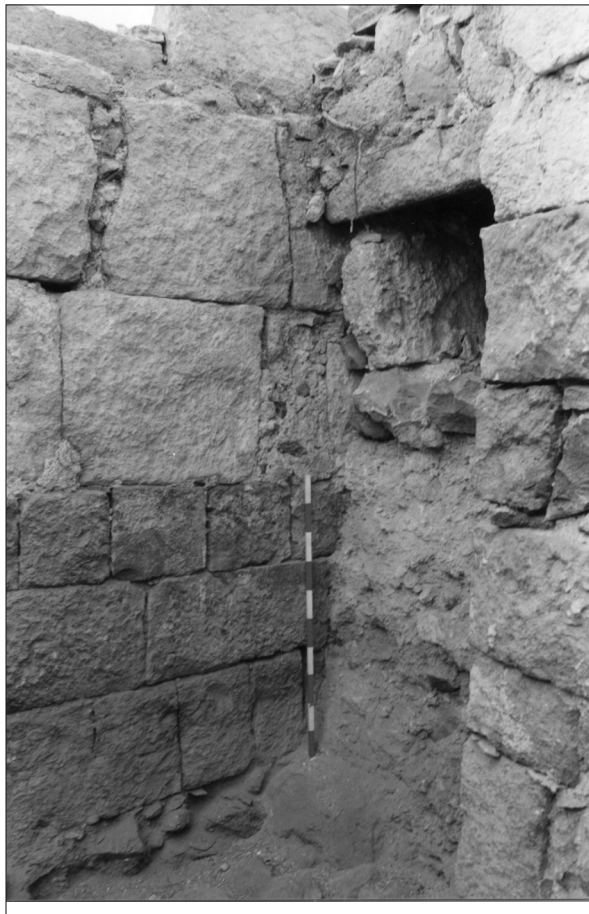
Fig. 8. Pomieszczenie L 207: narożnik południowo-wschodni. Fot. J. Burdajewicz.
