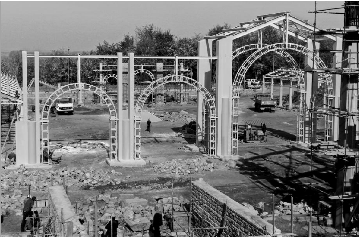
Fig. 3. Novae. The headquarters building during revitalization works in August 2013. Overhead view from the south-east (Photo T. Sarnowski). Ryc. 3. Novae. Komendantura legionowa w czasie prac rewitalizacyjnych w sierpniu 2013 r., widok z południowego wschodu.
