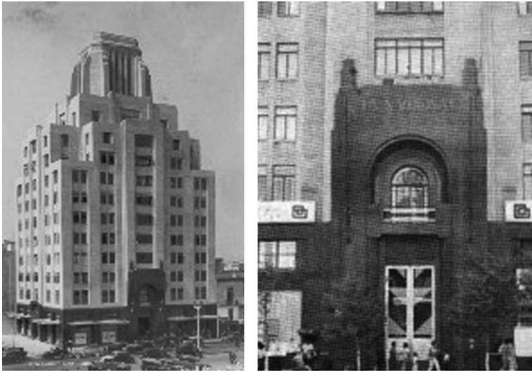
[Fig. 2. Edificio de La Nacional 20 .]
