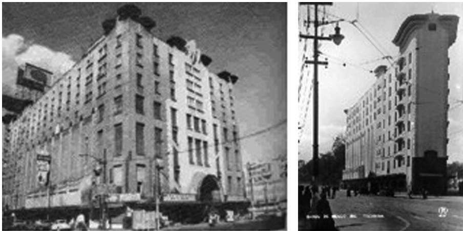
[Fig. 3. Edificio Ermita 21 .]
