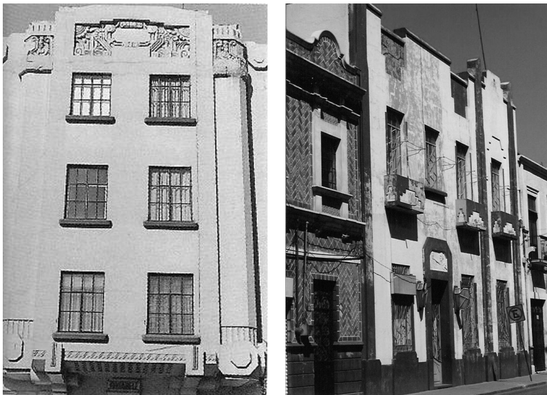
[Fig. 12. Colonia Hipódromo-Conesa, Edificio Picadilly (Insurgentes 309); Ciudad de Puebla, 9 Sur 107 (Centro).]
