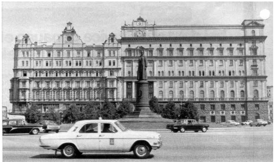
Илл. 3. Алексей Щусев, здание НКВД в Москве на Лубянской площади, 1936
