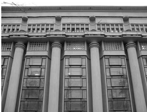
Илл. 4. Д. Ф. Фридман, центральная электротяговая подстанция Московского метрополитена, 1934–1935, фрагмент главного фасада
