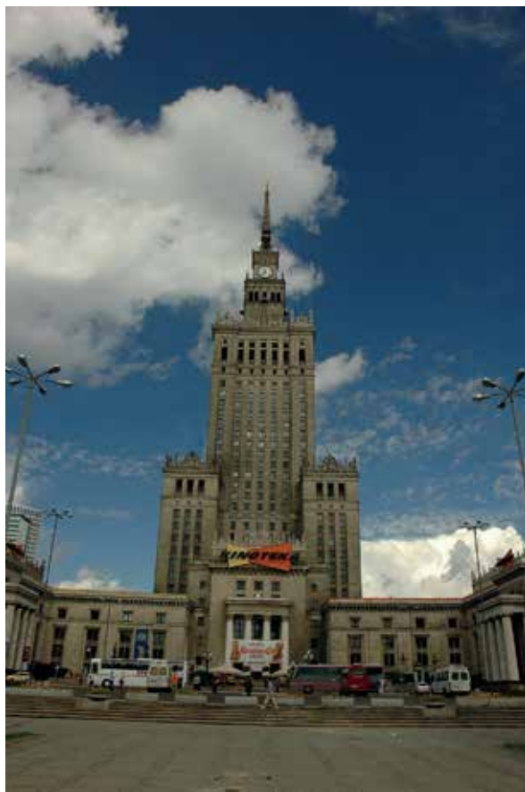
Il. 1. Pałac Kultury i Nauki, Warszawa, arch. Lew Rudniew z zespołem, fot. W. Kamiński
