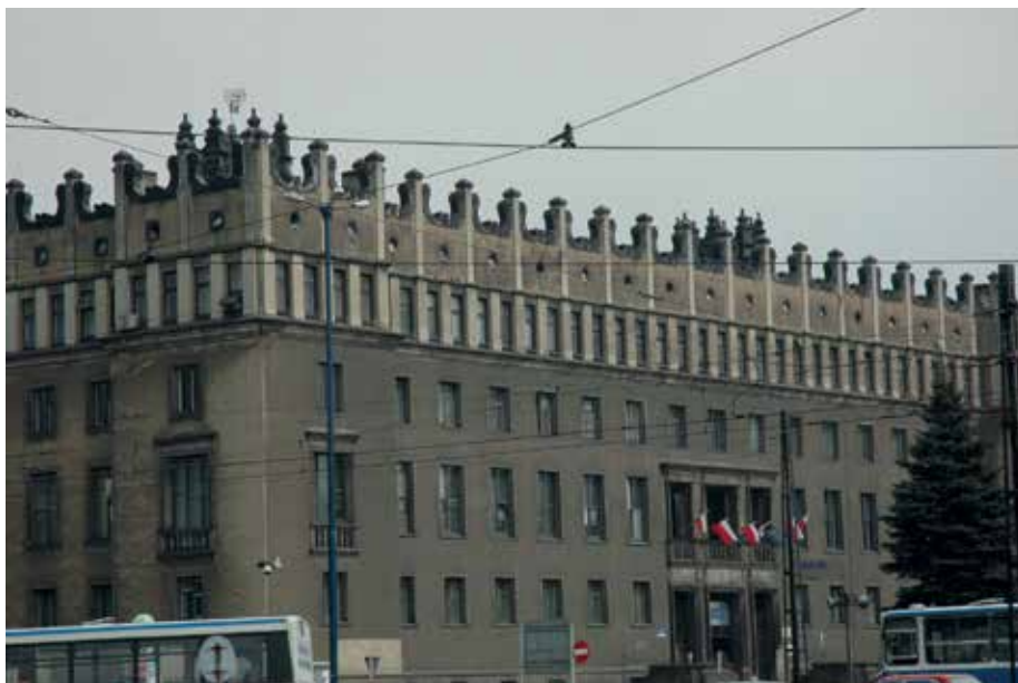
Il. 2. Nowa Huta, budynek centrum administracyjnego, arch. J. Ingarden, fot. W. Kamiński
