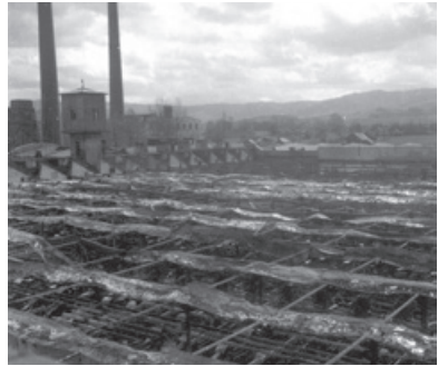
Widok od strony północnej na spaloną halę tkalni. W głębi po lewej stronie za kominem widać pozbawiony dachu budynek siłowni. Zdjęcie A. Stuglika w zbiorach AP w Katowicach Oddział Oświećim.
