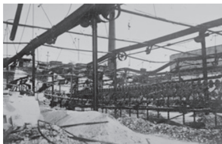
Wypalona hala tkalni – widok od południa; widoczne wały transmisyjne, które przenosiły napęd od maszyny parowej do krosien. Zdjęcie A. Stuglika w zbiorach AP w Katowicach Oddział Oświęcim.
