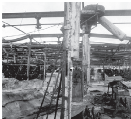
Inny widok wypalonej hali tkalni. Zdjęcie A. Stuglika w zbiorach AP w Katowicach Oddział Oświęcim.
