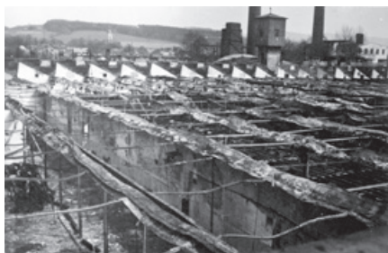
Widok od zachodu na kompletnie wypaloną halę tkalni; w głębi charakterystyczny shedowy dach wykańczalni. Zdjęcie A. Stuglika w zbiorach AP w Katowicach Oddział Oświęcim.
