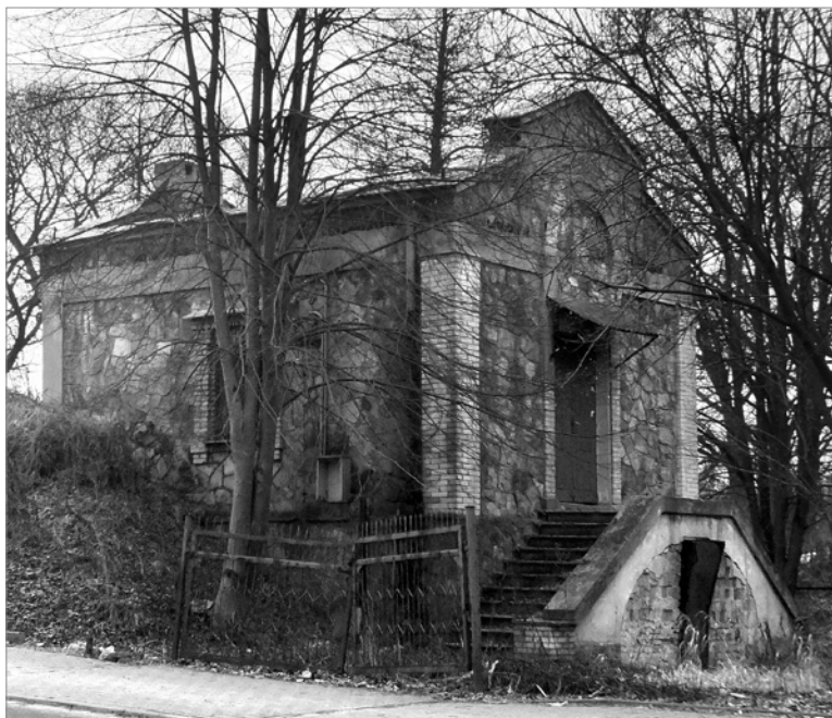
Pozostałości dawnej infrastruktury wodociągowej, przepompownia na Górnej Kolonii, stan obecny, fot. P. Kardys
