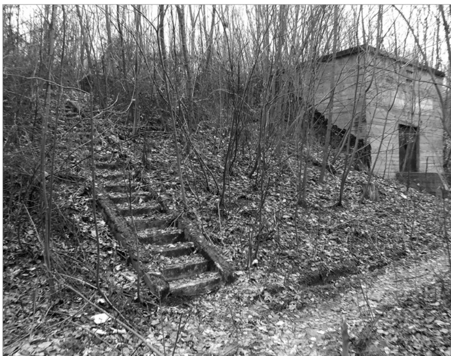
Zbiornik ZB 1 , Górna Kolonia, stan obecny, fot. P. Kardyś
