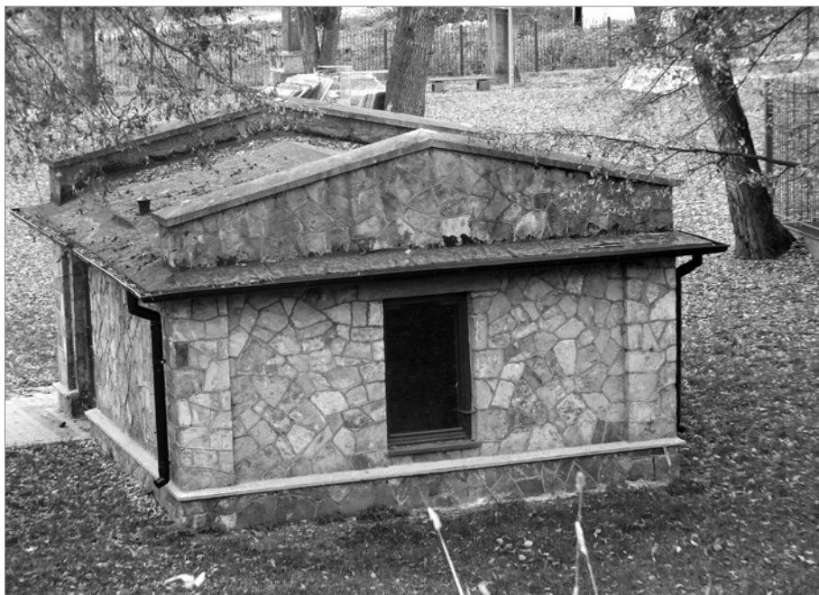
Pozostałości infrastruktury wodociągowej z końca lat 30. XX w. Przepompownia wody dla osiedla przy ul. Robotniczej, fot. P. Kardys
