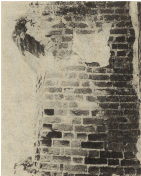
Ryc. 21. Besiekiery, zamurowana dziura po oporze sklepiennym w pomieszczeniu IV (narożnik południowo-zachodni)
