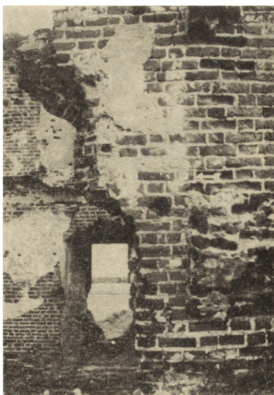
Ryc. 18. Besiekiery, wyjście łuku arkadowego na południowej fasadzie domu zamkowego
