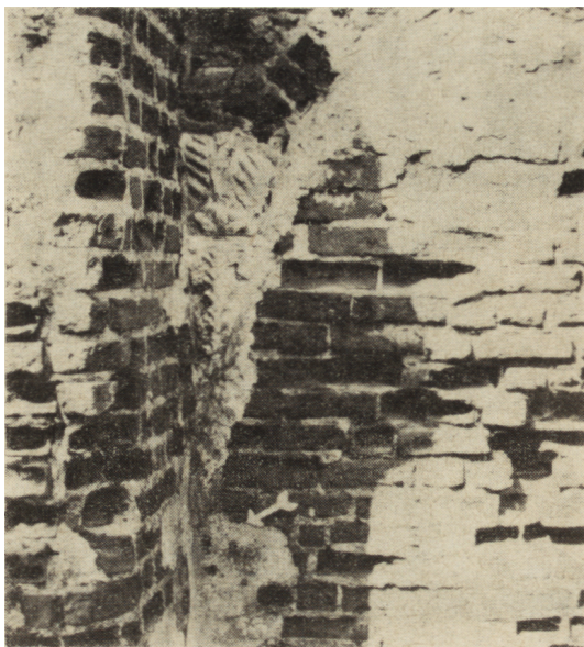
Ryc. 22. Besiekiery, nałożone zębra stiukowe na opór sklepienia krzyżowego
