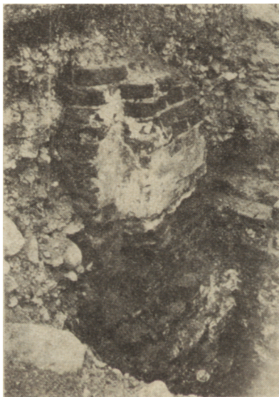
Ryc. 17. Besiekiery, dostawiony do muru wschodniego filar arkad z przebudowy dziedzińca zamkowego (ryc. 10, 3)
