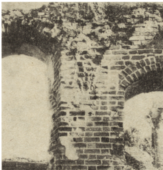
Ryc. 20. Besiekiery, opór sklepienia krzyżowo-żebrowego na osi południowej ściany pomieszczenia III
