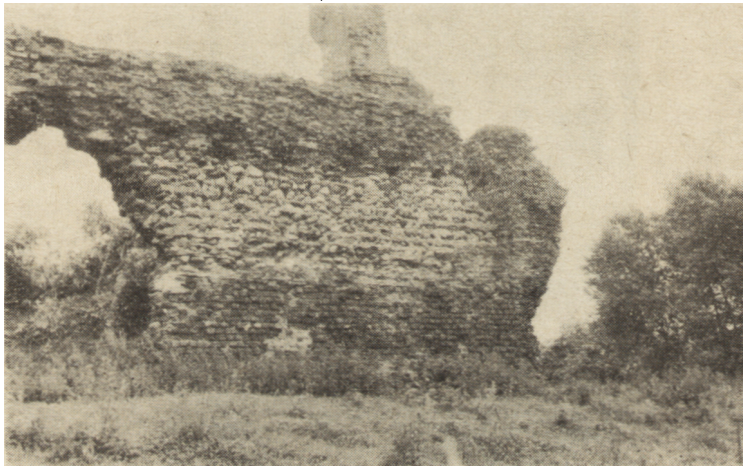
Ryc. 25. Besiekiery, struktura wewnętrzna muru zachodniego
