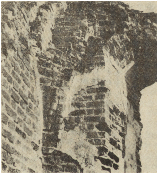
Ryc. 19. Besiekiery, opór sklepienia krzyżowo-żebrowego w narożniku południowo-wschodnim pomieszczenia III
