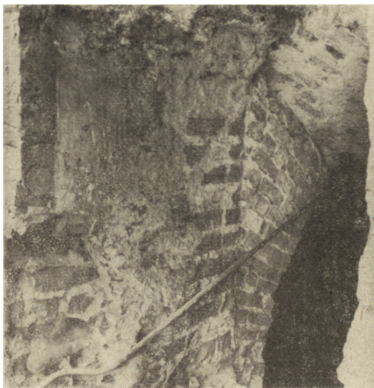
Ryc. 10. Lutomiersk, sklepienie piwniczne dobudowane w XVII w. do muru domu zamkowego
