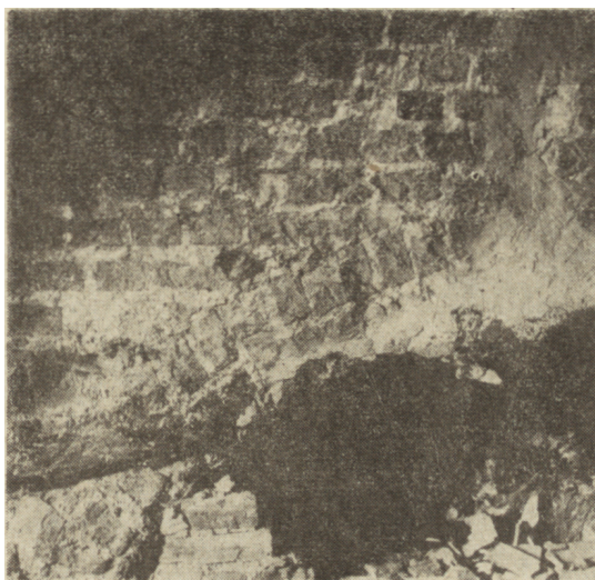
Ryc. 14. Lutomiersk, struktura średniowieczna w zachodnim szczycie domu zamkowego (widoczna wnęka kominkowa)
