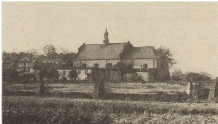
Ryc. 15. Lutomiersk, ogólny widok klasztoru skrywającego bryłę zamku średniowiecznego (widok od NE)
