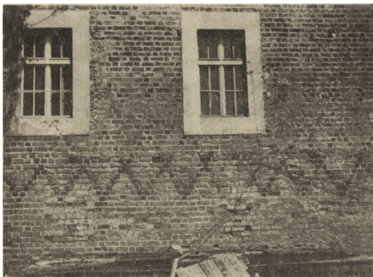
Ryc. 11. Lutomiersk, dekoracja ceglana w przyziemiu południowej ściany domu zamkowego
