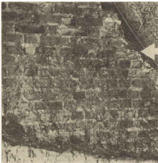
Ryc. 13. Lutomiersk, struktura średniowieczna we wschodnim szczycie domu zamkowego (strzałką oznaczono granicę między murem cienkim i murem wtórnie skutym)
