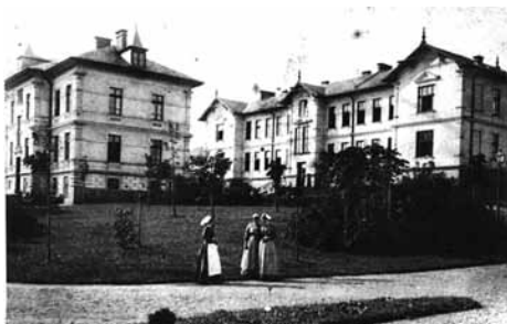
Ryc. 6. Główny pawilon dla chorych im. Cesarza Franciszka Józefa (po lewej stronie) oraz budynek administracji Szpitala Śląskiego (po prawej stronie). Pocztówka (1896 r.)
