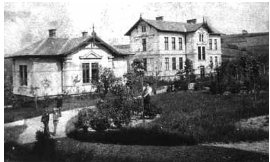
Ryc. 5. Budynek prosekury i oddział chorób zakaźnych (1894 r.)
