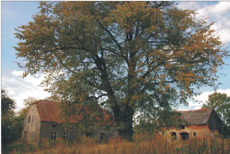
Rys. 3. Pomnikowa lipa w obrębie opuszczonej sadyby gospodarskiej. Fot. A. Martuszewski Fig. 3. Monumental lime-tree on an abandoned farm. Phot. A. Martuszewski
