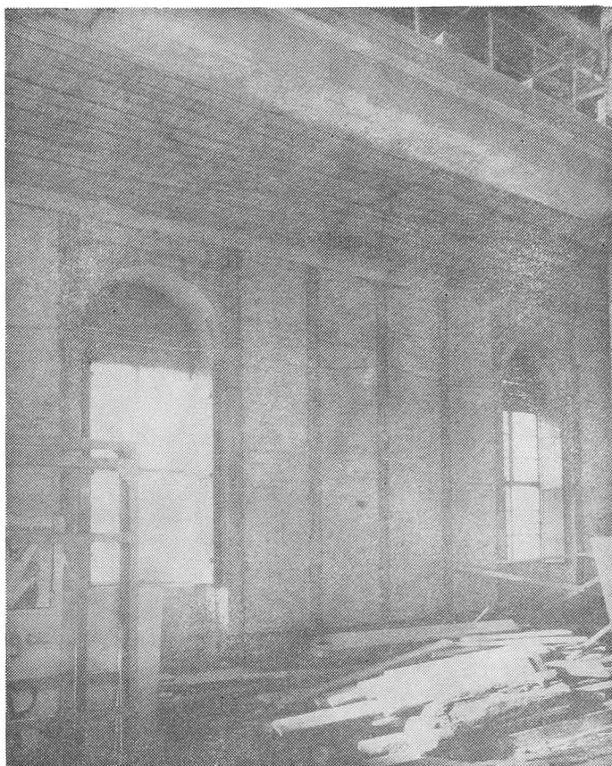
Fot. 9. Kościół św. Trójcy w Toruniu, pomocnicze konstrukcje drewniane wzmacniające ściany obwodowe w związku z ich podwyższeniem (fot. W. Górski)
