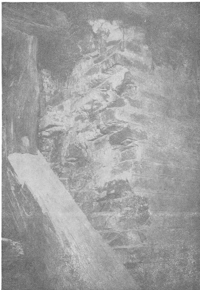
Fot. 8. Kościół św. Trójcy w Toruniu, ślady po rozbiórce pozostałości dawnej ściany bocznej nawy środkowej przy południowo-wschodnim narożniku wieży (fot. A. Skowroński)
