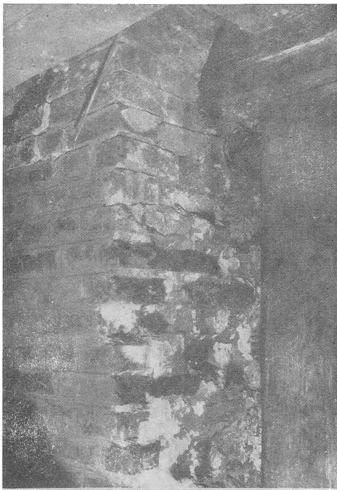
Fot. 7. Kościół św. Trójcy w Toruniu, ślady po rozbiórce pozostałości dawnej ściany bocznej nawy środkowej przy południowo-zachodnim narożniku wieży (fot. A. Skowroński)
