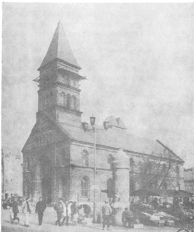
Fot. 10. Kościół św. Trójcy w Toruniu, ukończony w 1824 r. wg zmienionej koncepcji jako budynek o układzie salowym. Stan obecny. Widok od północnego wschodu (fot. W. Górski)
