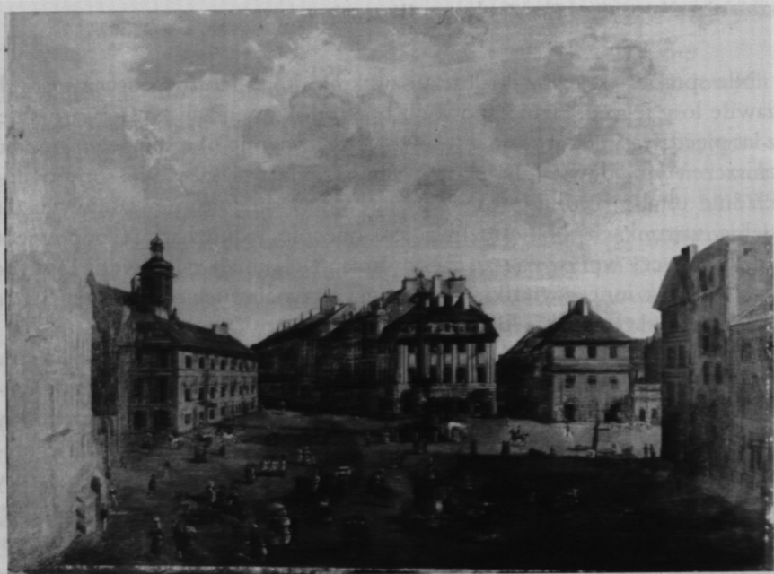
1. Widok placu Zamkowego, lico obrazu przed konserwacją.
