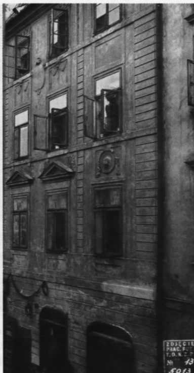
6. Fotografia J. Kłosa kamienicy ul. Nowomiejska 1 z pieczętką TOnZP z 1916 r.
