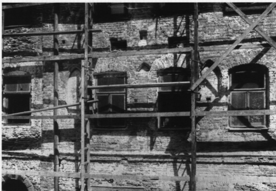
7. Kamienica Świętojańska 14 – odsłonięte wnętrza gotyckie podczas remontu w 1928 r.
