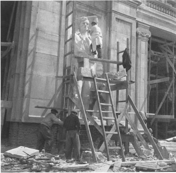
28. Budowa MDM - prace wykończeniowe przy socrealistycznej płaskorzeźbie, fot. E. Hartwig, 1952 r.
