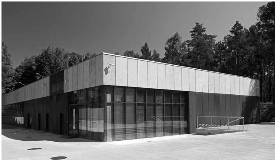
2. Budynek Muzeum – Miejsca Pamięci Palmiry według projektu biura architektonicznego WXCA
