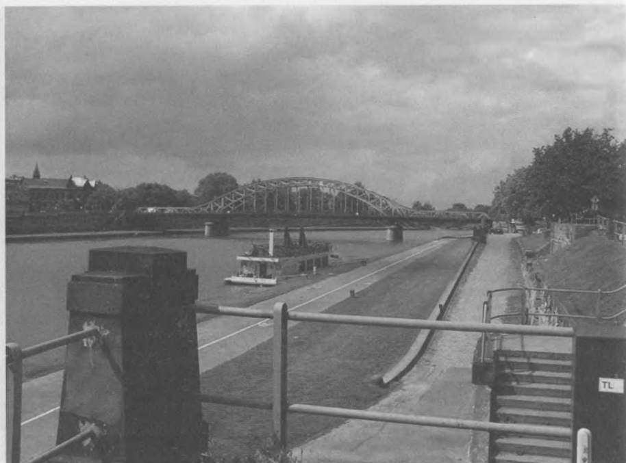
Ryc. 15 – Fragment bulwarów wiślanych. (Fot. Tomasz Wieja)
