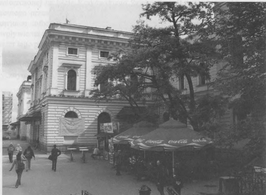
Ryc. 3 – Budynek stacji kolejowej Kraków Główny. (Fot. Tomasz Wieja)
