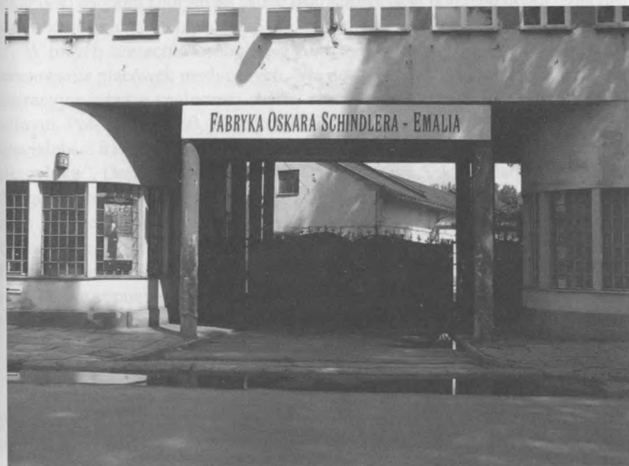
Ryc. 18 – Fabryka Oskara Schindlera – stan aktualny. (Fot. Tomasz Wieja)
