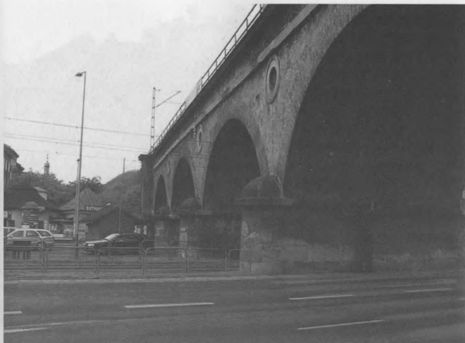
Ryc. 9 – Wiadukt kolejowy nad ul. Dietla. (Fot. Tomasz Wieja)
