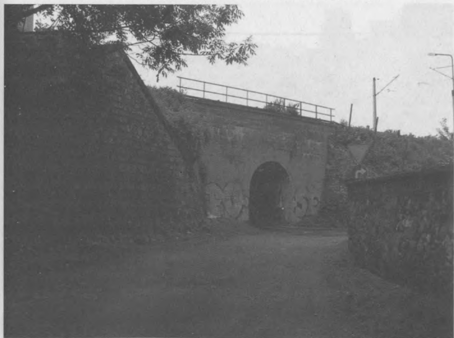
Ryc. 10 – Przepust drogowy nad ul. Miodową. (Fot. Tomasz Wieja)
