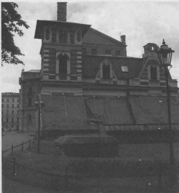
Ryc. 6 – Elektrownia Teatru Miejskiego im. J. Słowackiego. (Fot. Tomasz Wieja)
