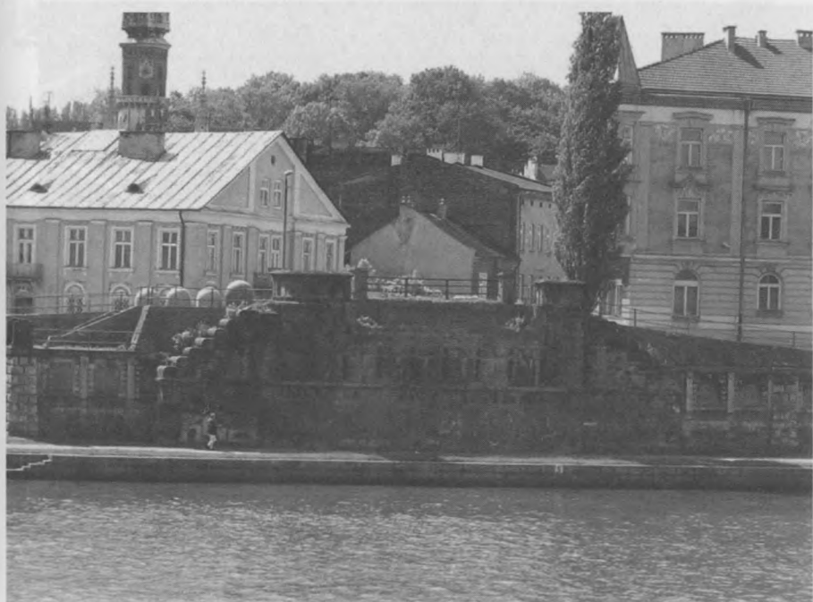
Ryc. 14 – Przypory mostu Podgórskiego. (Fot. Tomasz Wieja)
