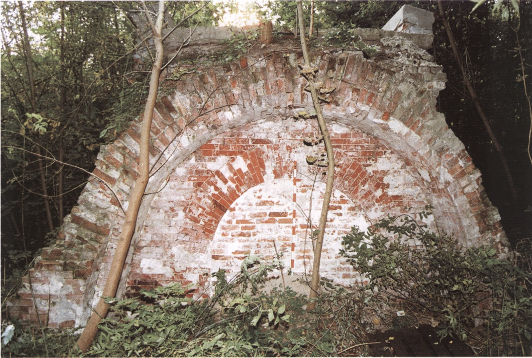
Ryc. 5. Dęblin, pow. rycki, stan. 3. Twierdza – zamurowany korytarz poterny. Fot. J. Tkaczyk.
