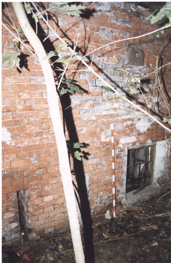
Ryc. 3. Dęblin, pow. rycki, stan. 3. Twierdza – północno-zachodni mur poterny z widoczną strzelnicą dla broni ręcznej i otworem okiennym; powyżej tzw. rzygacz. Fot. J. Tkaczyk.
