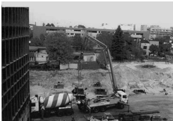
Il. 9. Budowa nowego gmachu BUŁ. Źródło: Archiwum BUŁ
