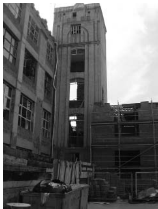
II. 1. Remont budynku Biblioteki AHE. Źródło: Archiwum AHE
