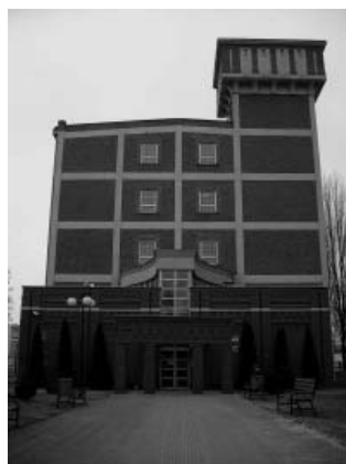
Il. 6. Budynek Biblioteki PŁ po remoncie. Fot. M. Kowalska
