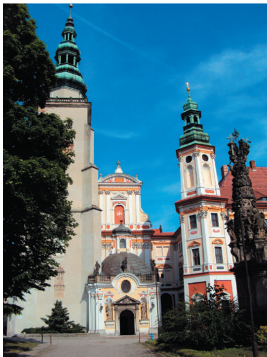
Ryc. 4. Fasada kościoła opackiego w Henrykowie i północno-zachodni fragment klasztoru. Fot. B. CZECHOWICZ
