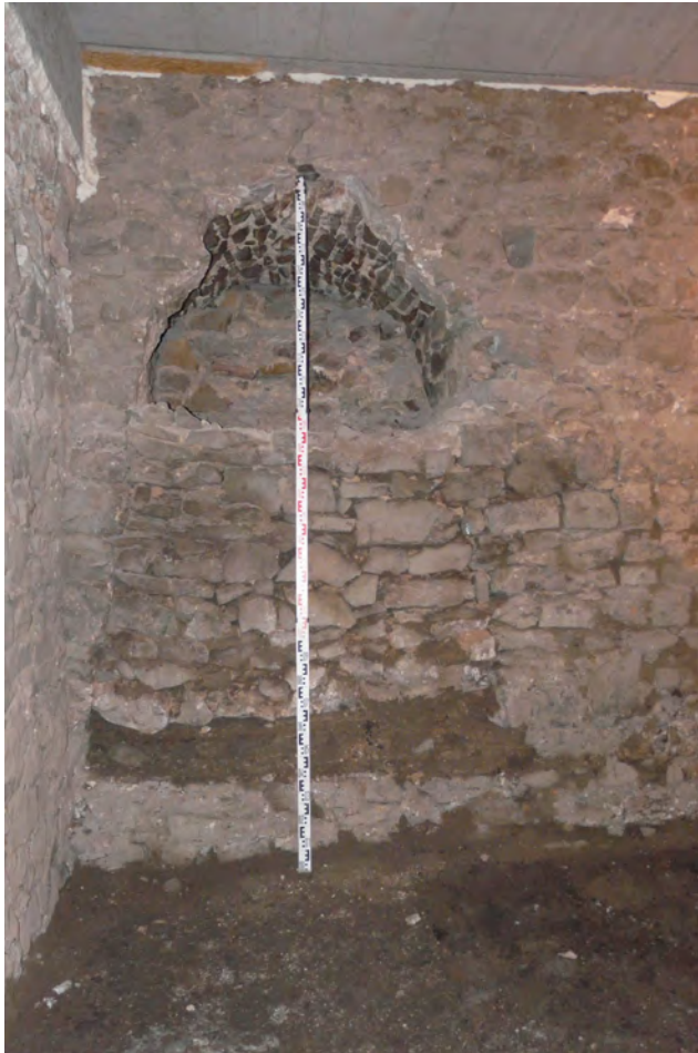
Ryc. 3. Święty Krzyż, klasztor, północno-wschodnie naroże krużganków. Zamurowane przejście w murze wschodnim. Fot. C. HADAMIK
