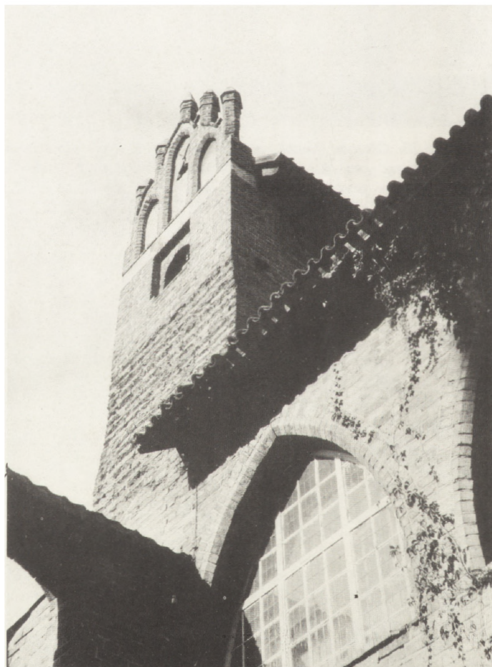
Ryc. 15. Olsztyn, zamek: zdaniem E. Zinnera, Kopernik mógł wykonywać swe obserwacje za pomocą narzędzi astronomicznych z nadbudówki na koronie muru kurtynowego, tuż ponad krążankiem. Fot. Jerzy Rudke, Archiwum PSOZ
