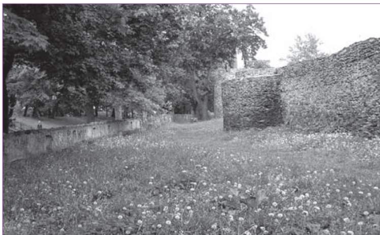
2. Dzierżonów. Mury miejskie, dobrze zachowany odcinek z warstwami wyrównawczymi w murze wewnętrznym i otworami strzelniczymi w przedmurzu.
