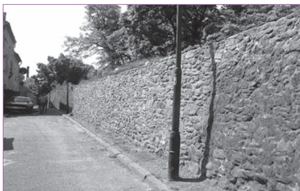
1. Niemcza. Mury miejskie, odcinek zachodni od wewnątrz. Wszystkie fot. B. Nowak-Obelinda.
