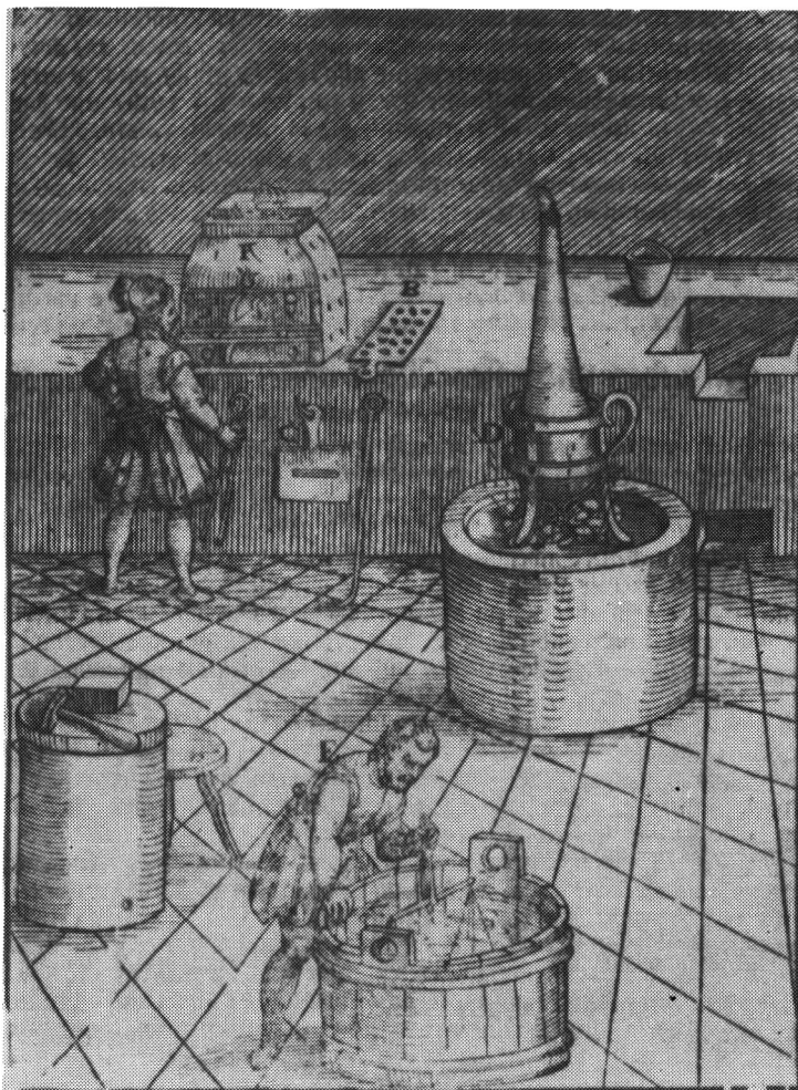
Ryc. 12. Laboratorium probiercze, m.in. do oddzielania złota od srebra przy pomocy kwasów według L. Erckera; A — piec probierczy; B — blacha żelazna, na którą wylewa się próbki, C — drewniana deszczułka ze szczeliną, przez którą obserwuje się wnętrze pieca, D — kolba probiercza, E - wążenie srebra w wodzie
