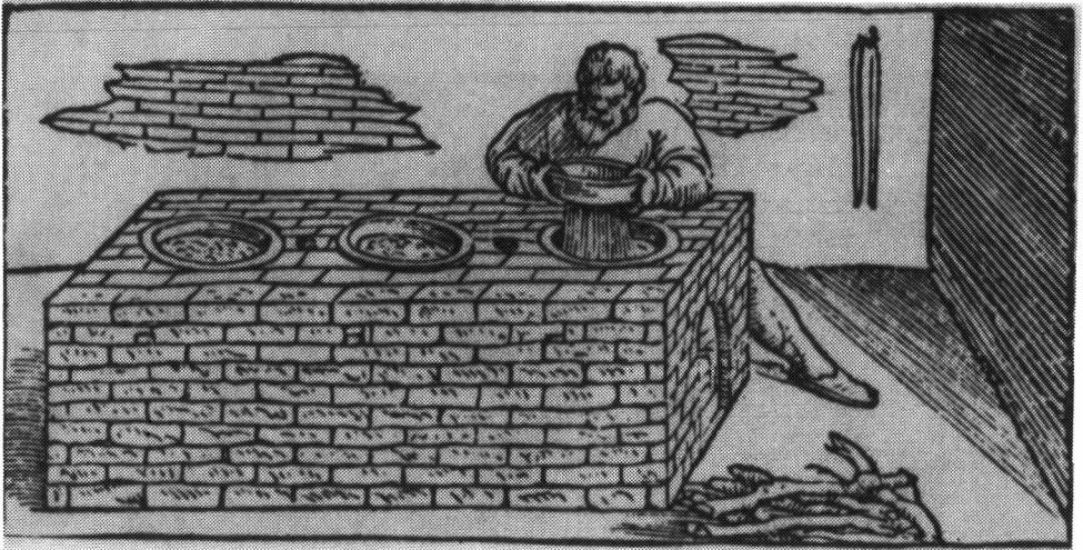
Ryc. 10. Budowa pieca z łaźnią piaskową do wyrobu destylacji kwasu azotowego według V. Biringuccia
