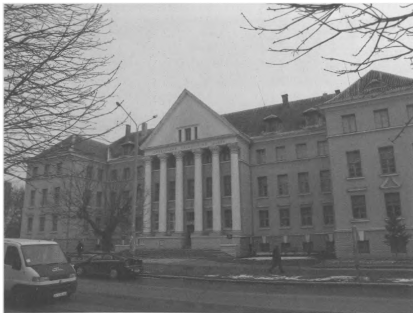
Budynek dawnego Okręgowego Urzędu Ziemskiego, wzniesiony w latach 1928-1930 wg projektu łuckiego architekta, Kazimierza Janickiego. Siedziba Wołyńskiego Muzeum Krajoznawczego w Łucku od 1985 r. Fot. Autor
