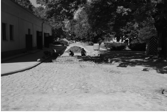
Przekładanie nawierzchni brukowej na terenie muzealnym
