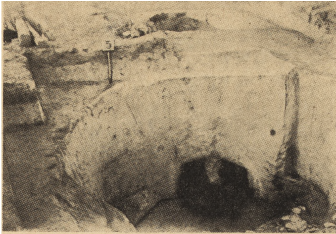
Ryc. 62. Igołomia. Widok pieca nr 5 od strony jamy przy- piecowej.
