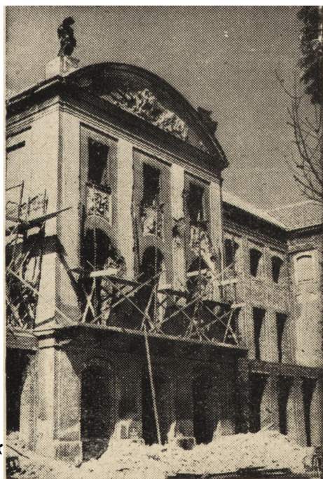
Ryc. 56. Warszawa, pałac Kazimierzowski, fragment elewacji wschodniej po odbudowie.
