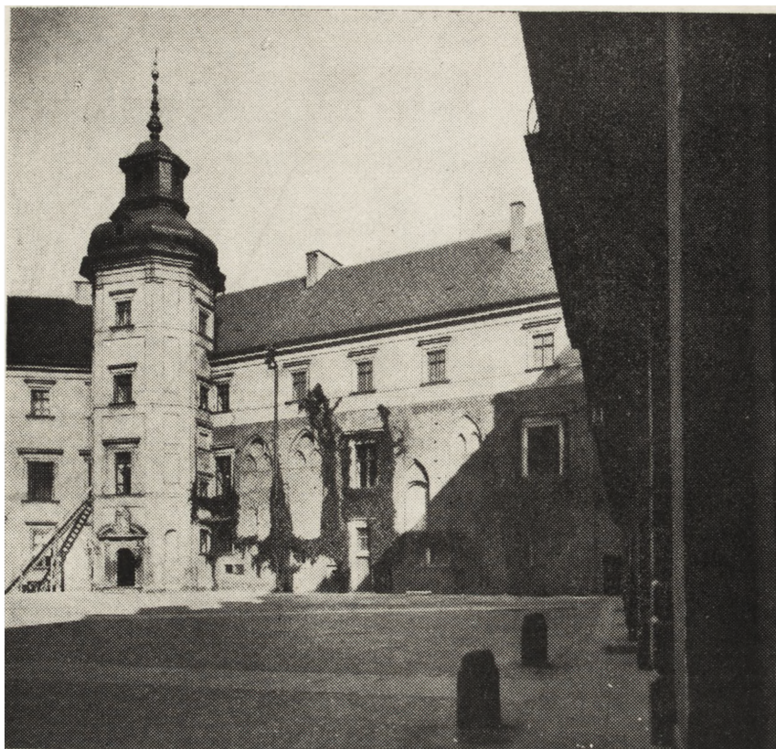
Ryc. 181. Zamek Warszawski. Elewacja „Domu Dużego“ po wykonaniu robót konserwatorskich.
