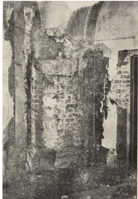
Ryc. 184. Zamek Warszawski. Stan sali o jednym słupie w czasie remontu w r. 1921.
