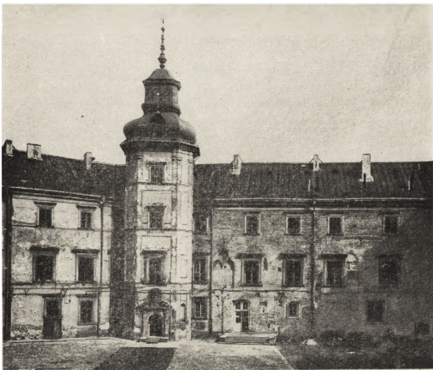
Ryc. 177. Zamek Warszawski - część gotycka po odbieniu tynków i przed przystąpieniem do restauracji.
