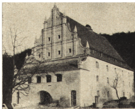
Ryc. 95. Spichlerz na Krakowskim Przedmieściu. Grupa II. Widok po odbudowie.
