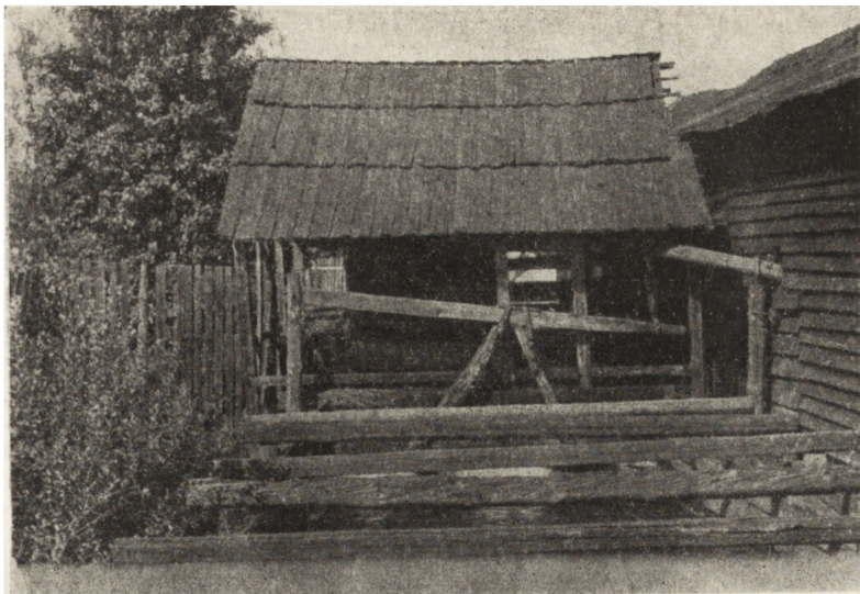
Ryc. 103. Maleniec — koryto wodne, stawidło i koło napędowe. Widok od wschodu. fol. Kozakiewiczowa
