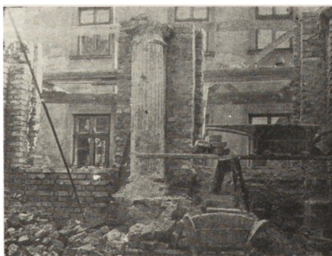
Ryc. 159. Kraków — wnętrze kamienicy przy ul. Józefa 40. Stan z r. 1951.
