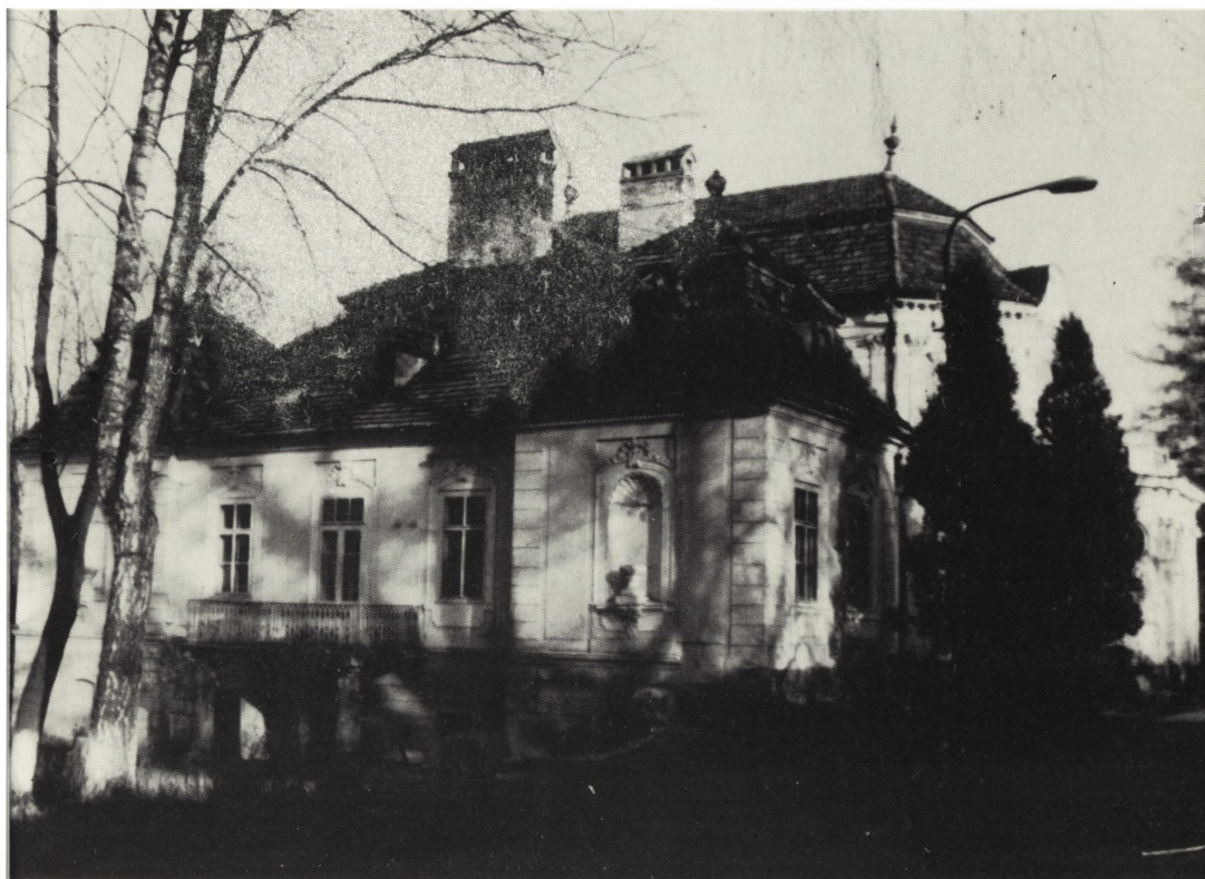
Pałac Jabłonowskich w Lubieniu od strony południowo-zachodniej
