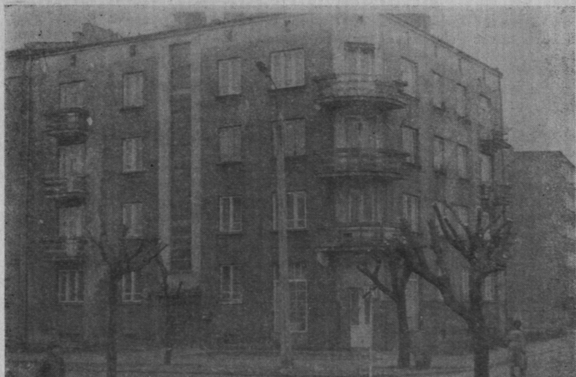
Dom przy ul. Kraszewskiego (naprzeciw przystanku WKD) związany z tajnym nauczaniem
