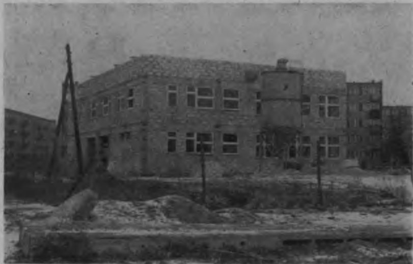
Przedszkole na osiedlu „Nowa Wieś” — w budowie.
