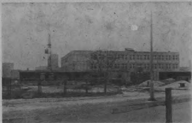
Szkoła podstawowa (środowiskowa) na osiedlu „Nowa Wieś” w budowie. Oddanie jej do użytku przewidziane jest na początek roku szkolnego 1984—85. Odciążą nadmierne „zagęszczenie” sąsiednich szkół nr 8 i nr 11. Foto nr 38
