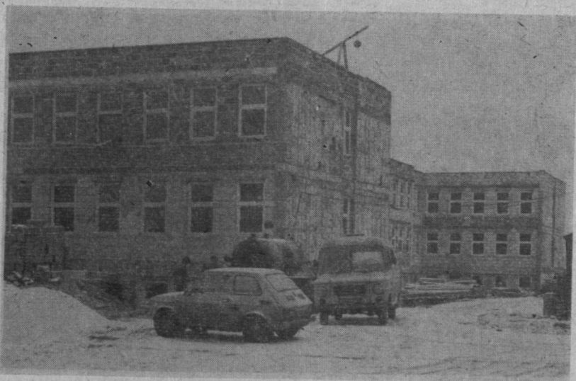
Pawilon szpitalny w budowie — ujęcie od strony istniejącego szpitala Miejskiego na Wrzesinie.
