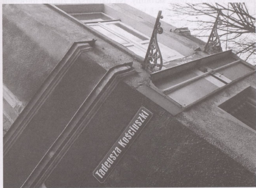
Elewacja narożna – tak wyglądała pozostałość po balkonie
