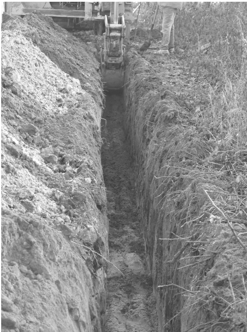
Fot. 9. Wohyń, pow. Radzyń Podlaski. Stratygrafia wykopu pod gazociąg w ul. Łąkowej, na południowej terasie Piwonii.
