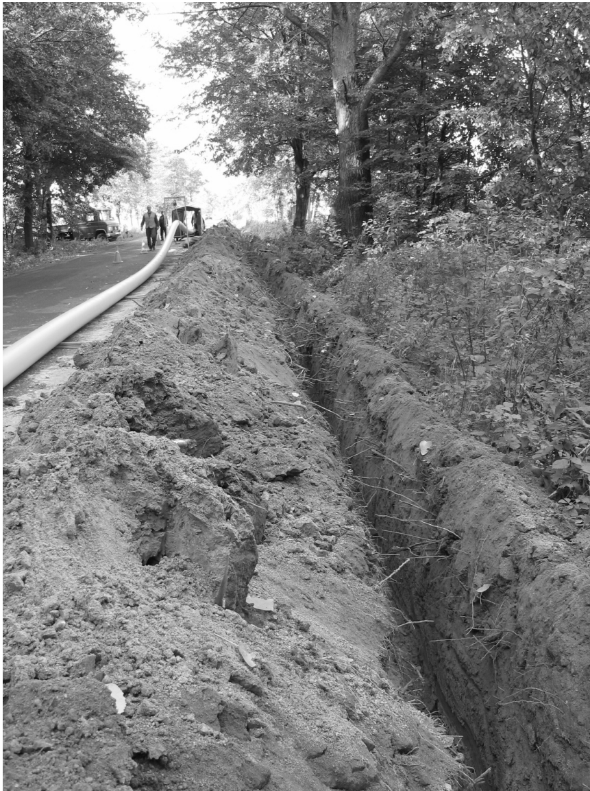
Fot. 15. Milanów, pow. Parczew, okolice stan. 2. Wykop pod gazociąg budowany był zazwyczaj pomiędzy dywanikiem asfaltowym a rowem odwadniającym. Dlatego zwykle wykop nie sięgał calca.
