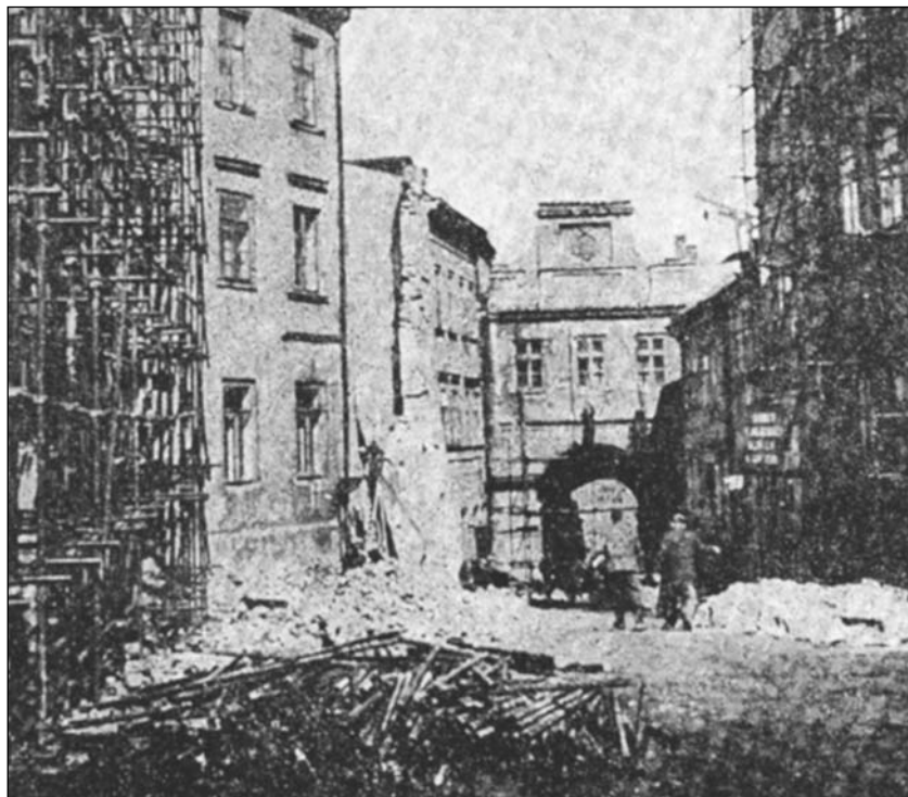
Fot. 1. Odbudowa ulicy Grodzkiej
