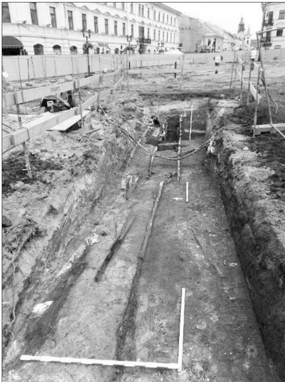
Ryc. 11. Widok na odcinek kanału burzowego, fot. Piotr Zimny
