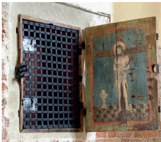
Fot. 7. Tabernakulum ścienne po konserwacji i restauracji, umieszczone w pierwotnej niszy w kościele pw. św. Piotra i Pawła w Mariance Pastęckiej. Konstrukcja nośna jest niewidoczna, natomiast umożliwiła uzyskanie dystansu pomiędzy drewnem szafki sakrarium a murem, sposób montażu pozwala na cyrkulację powietrza
