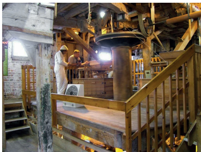
Fot. 3. Wnętrze młyna Mill Green Mill and Museum
