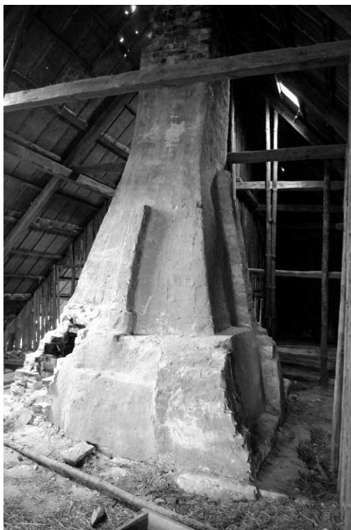
Fot. 2. Zborowskie, pow. lubliniecki. Górna część komina znajdującego się w centralnej części budynku
